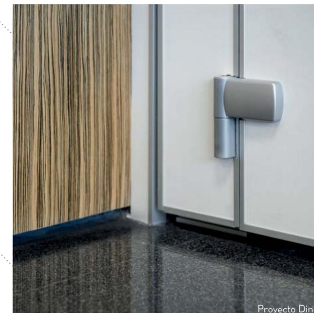
La puerta del tabique móvil tiene el mismo espesor que el tabique. La maneta está enrasada con el panel para un mejor apilamiento de los módulos.
